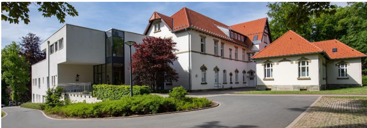
Abbildung 4: Gebäude 4 des LWL-Wohnverbundes auf dem LWL-Gelände Warstein
