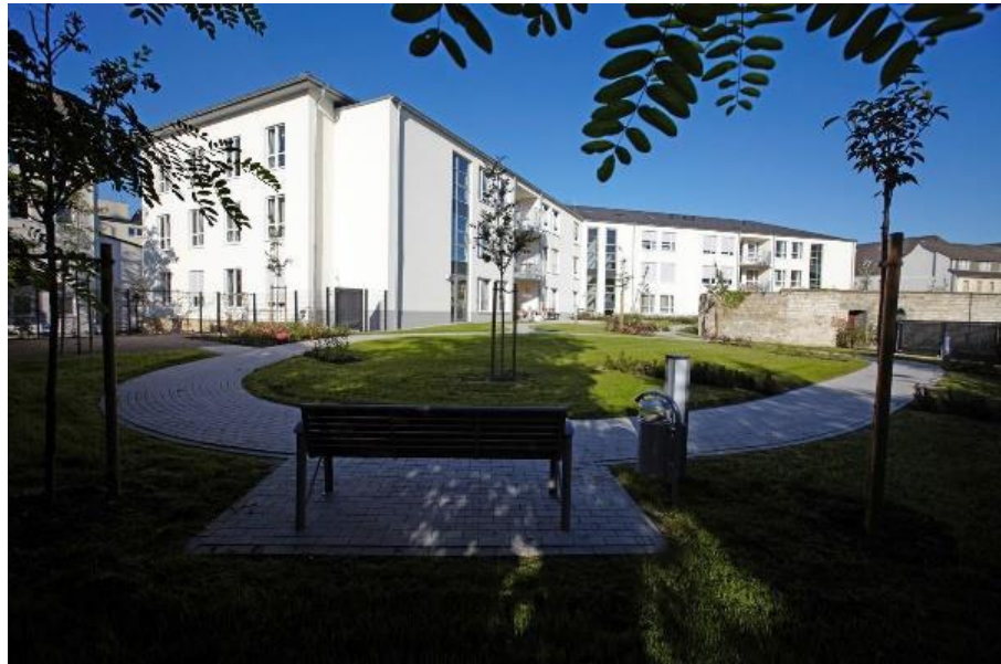
Abbildung 3: Gebäude des LWL-Pflegezentrums in Geseke
